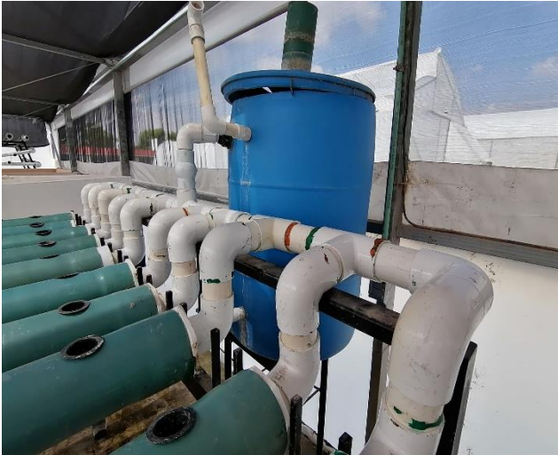
Fig. 7 En la figura se puede apreciar la parte frontal del sistema de acuaponía en forma piramidal, con sus tubos y conexiones de PVC respectivamente.
