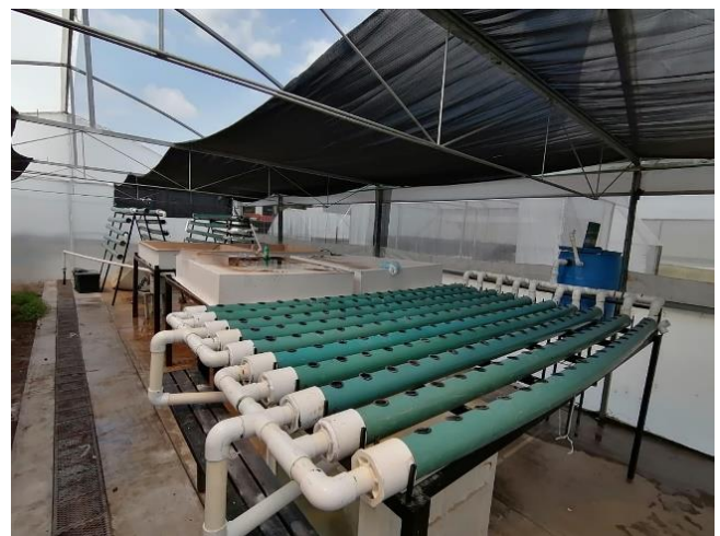
Fig. 2 Vista superior de la parte media del sistema acuapónico en paralelo.
